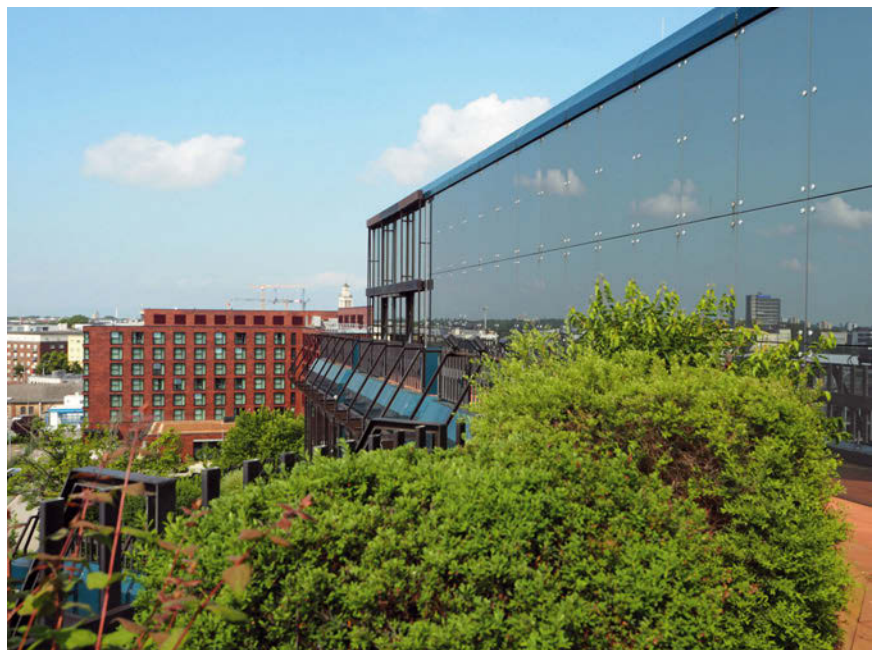
Abb. 1: Ab 2022 bietet das umfassend sanierte „Kronos“ moderne Büroflächen.
