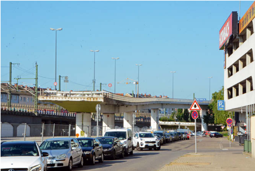
Abb. 4: Die Pilzhochstraße ist zwischenzeitlich abgerissen und wird durch einen Neubau ersetzt.
