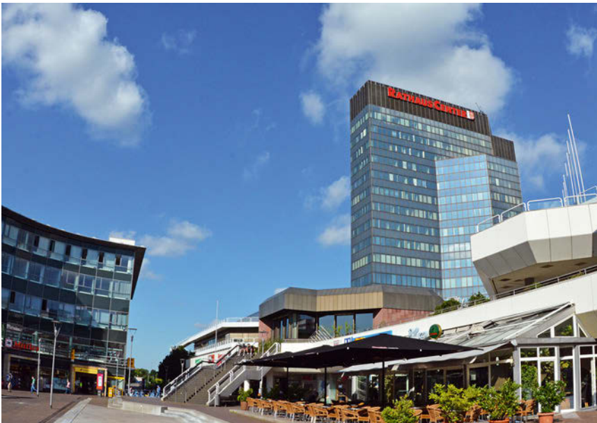
Abb. 5: Rathauscenter und Rathausurm sind marode und werden abgerissen.
