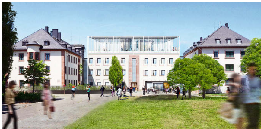
Abb. 12: Nach einer umfassenden Sanierung erstrahlt das H-Gebäude in neuem Glanz. Quelle: Kraus Gruppe
